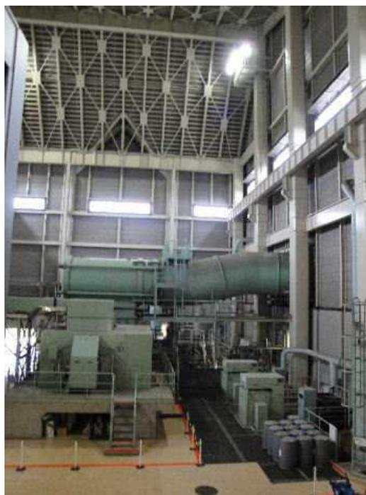
タービンと発電機、上部のパイプには蒸気が通っています。
