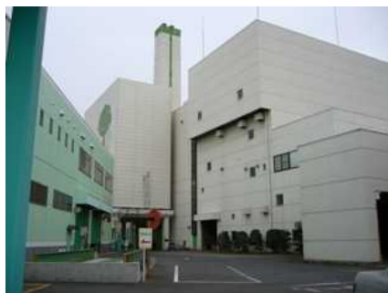
富士見環境センター 焼却施設 びん、缶、ペット、粗大、不燃処理
