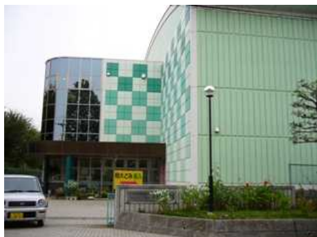
リサイクルプラザ利彩館 資源プラスチック中間処理施設 3R啓発施設が併設されている
